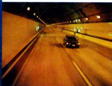
9,5 quilômetros de túnel
